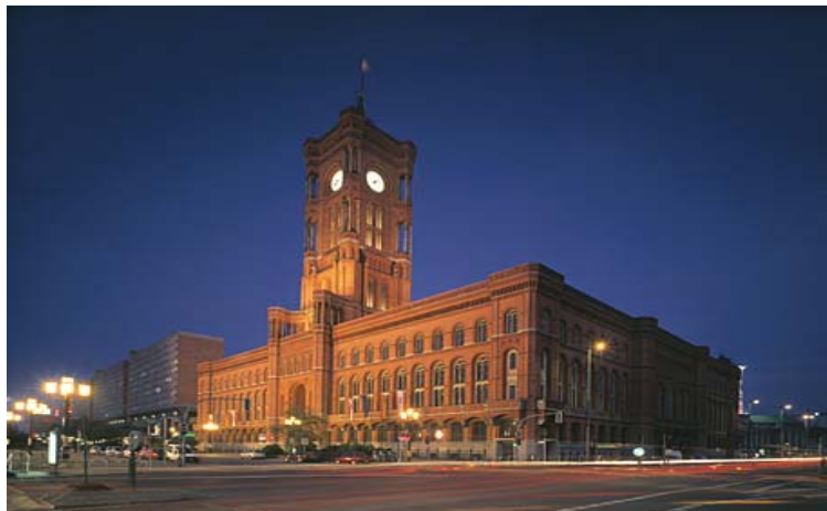
Auch das Berliner Rathaus ist Teil einer „Energiesparpartnerschaft“; die Investitionen zur Erneuerung der energietechnischen Anlagen refinanzieren sich aus den eingesparten Energiekosten. (Foto: Partner für Berlin / FTB Werbefotografie)
